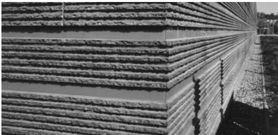
PROFIL KĄTOWY Z FAZĄ UWZGLĘDNIAJĄCY ŚRODKOWY PUNKT FAKTURY W BETONIE
