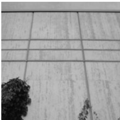
FAZA UWZGLĘDNIAJĄCA NAJNIŻSZY PUNKT FAKTURY W BETONIE
