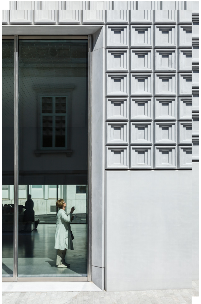
Projekt: Erweiterungsbau des Bündner Kunstmuseums Ort: Chur, Schweiz Architekt: Barozzi/Veiga
