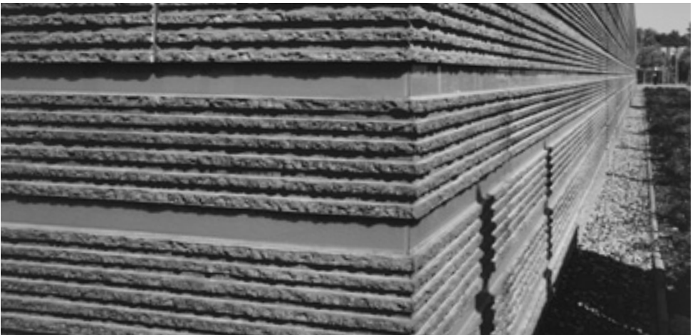
ECKPROFIL MIT FASE AUF STRUKTURMITTELPUNKT IM BETON
