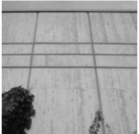
ECKFASE AUF STRUKTURTIEFPUNKT IM BETON
