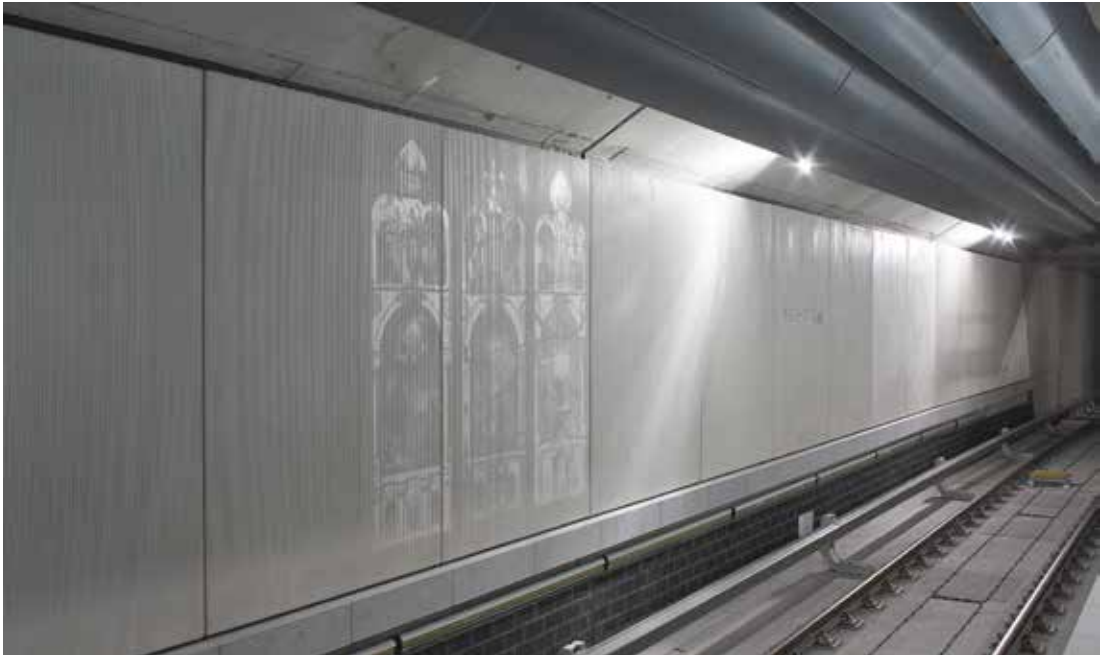
U-BAHNHOF KAULBACHPLATZ RECKLI FOTOGRAVUR NÜRNBERG DEUTSCHLAND, 2012
