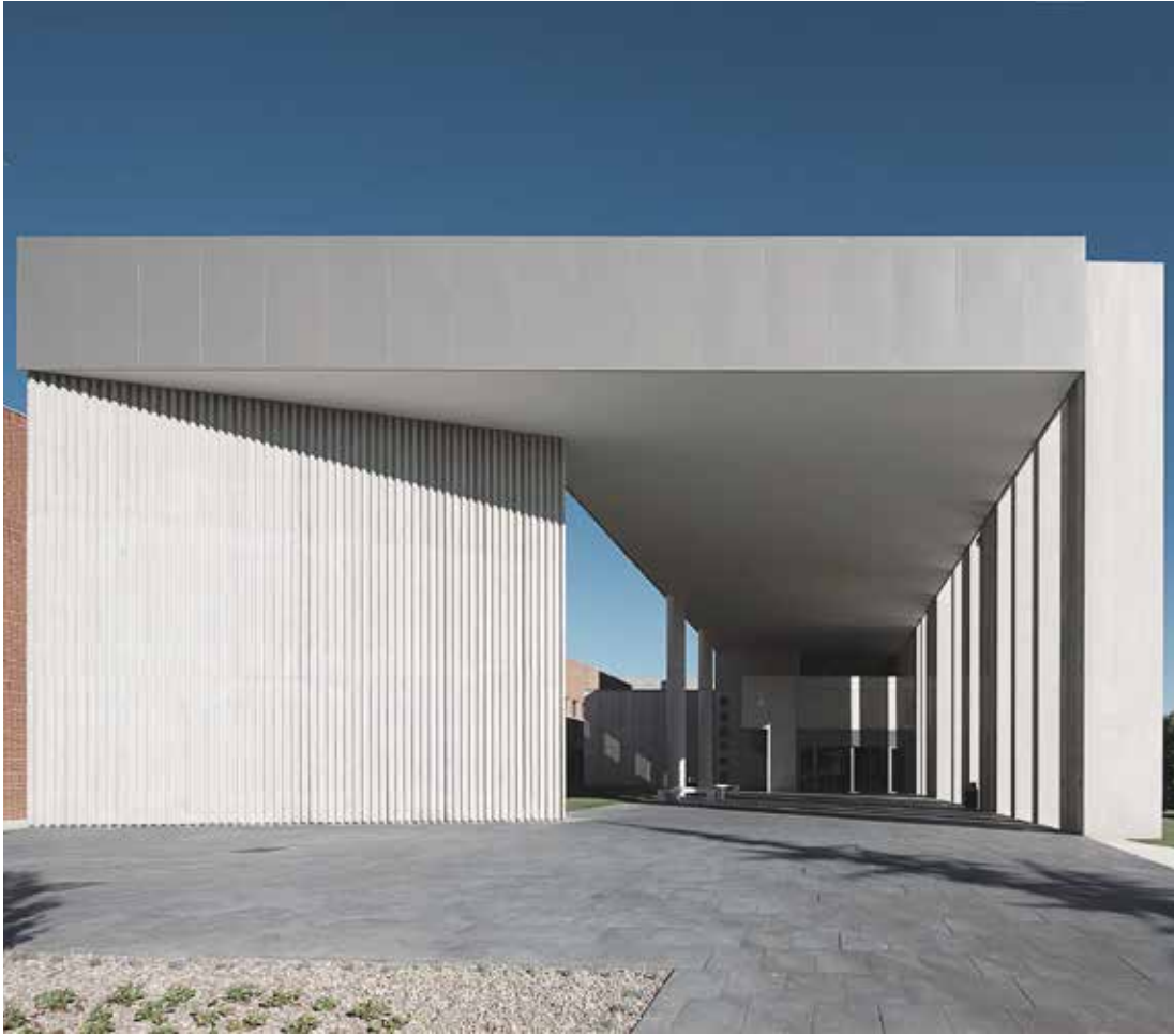
UNIVERSITÄT PAMPLONA RECKLI STANDARD 1/31 RIPPE TYPE C PAMPLONA SPANIEN, 2012
