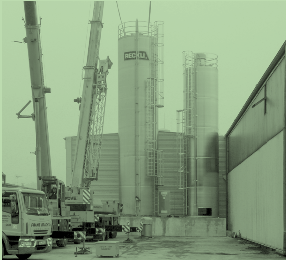
INSTALLATION DER RECKLI-SILOS
