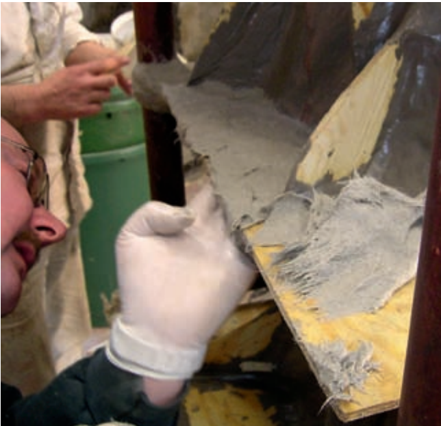
19 Anspachteln der Aussteifung mit Stützmasse EP-F Type VB
