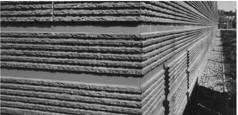
ECKPROFIL MIT FASE AUF STRUKTURMITTELPUNKT IM BETON
