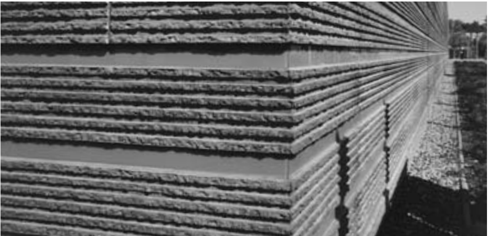
ECKPROFIL MIT FASE AUF STRUKTURMITTELPUNKT IM BETON
