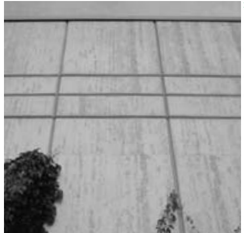
ECKFASE AUF STRUKTURTIEFPUNKT IM BETON
